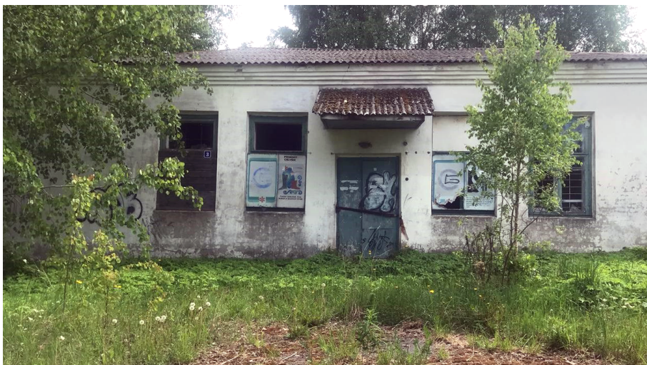
Рисунок 6. Здание, расположенное в Брейтовском районе, село Прозорово, ул. Рождественская, д. 3.
