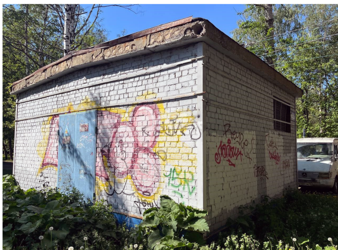
Рисунок 3. Здание электрощитовой, расположенное во дворе по адресу: г. Ярославль, ул. Володарского, д. 61 (центр города).
