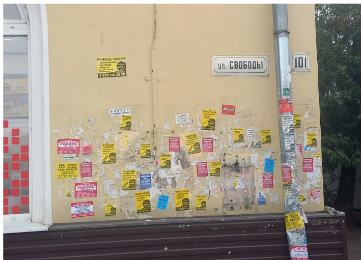
Рисунок 4. Здание жилого дома, расположенное по адресу: г. Ярославль, ул. Свободы, д. 101 (центр города).
